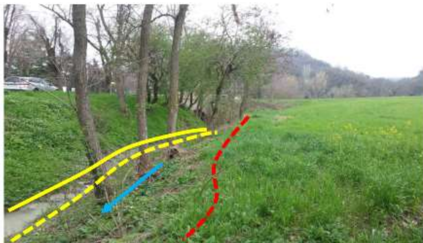
Sito di intervento Ante Operam (09/04/2013). In giallo continuo la sponda destra, in giallo tratteggiato la sponda sinistra pre intervento, in rosso la sponda sinistra arretrata.
