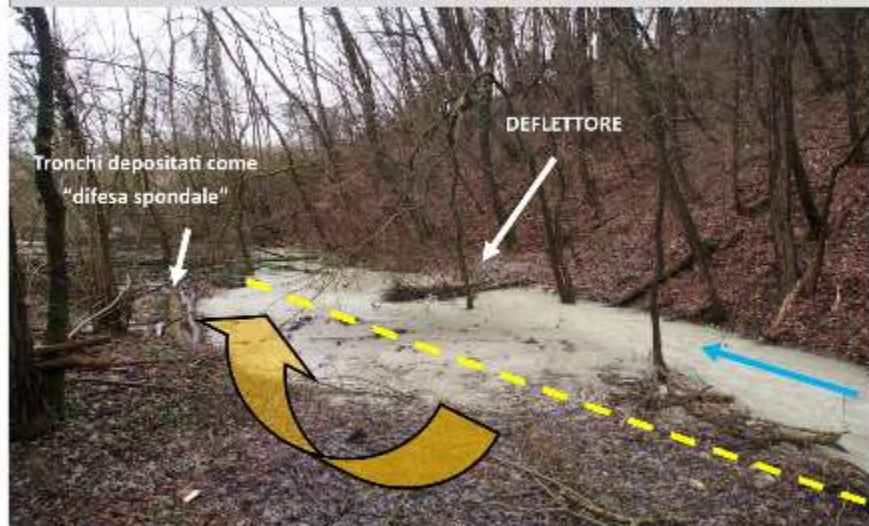
Rio Bertolini—Situazione dopo circa 6 mesi dal posizionamento del DEFLETTORE IN TRONCHI (25/02/2015). In giallo la sponda sinistra dell'alveo pre-intervento. In arancione la corrente deviata dall'intervento, con l'interessamento della piana inondabile.
