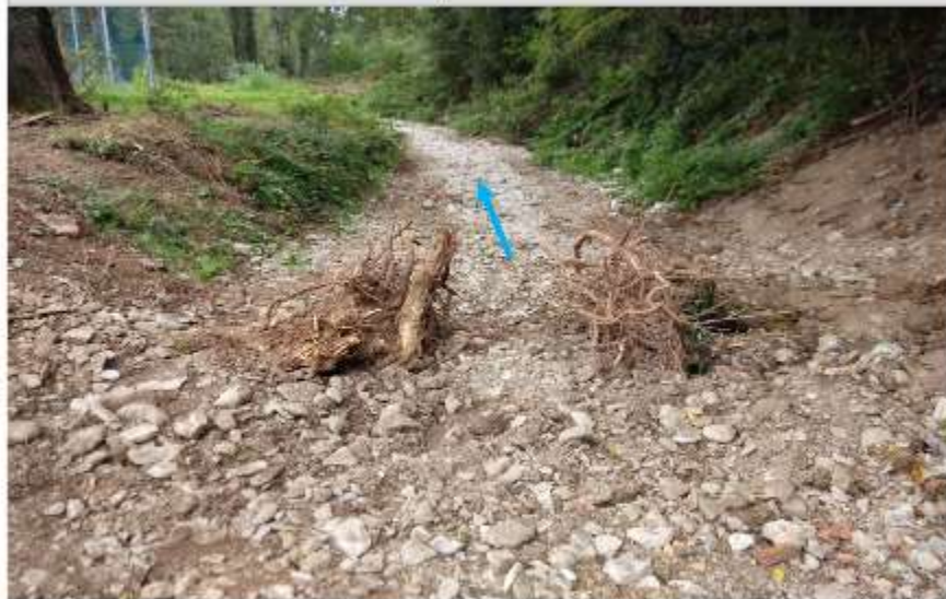
Rio Lavazza—SITO DI INTERVENTO AL TERMINE DEI LAVORI di posizionamento di TRONCHI CON RADICI ESPOSTE (05/09/2014)
