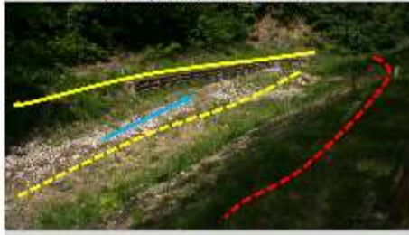
Una situazione di canale libero del Rio Enzola, in un tratto a valle della cascata, in cui il canale è stato allargato e il letto è stato ripulito.
