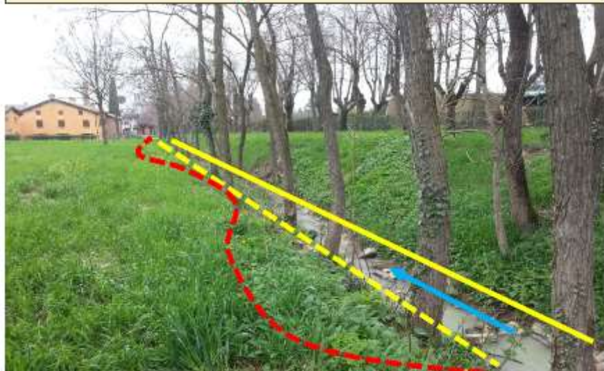
Sito di intervento Ante Operam (09/04/2013). In giallo continuo la sponda destra, in giallo tratteggiato la sponda sinistra pre intervento, in rosso la sponda sinistra arretrata.
