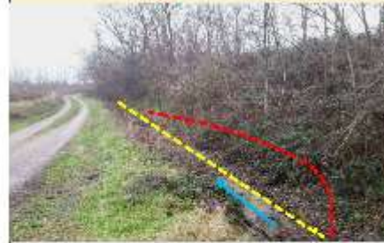
Una situazione di canale libero del Rio Enzola, in un tratto a valle della cascata, in cui il canale è stato allargato e il letto è stato ripulito.
