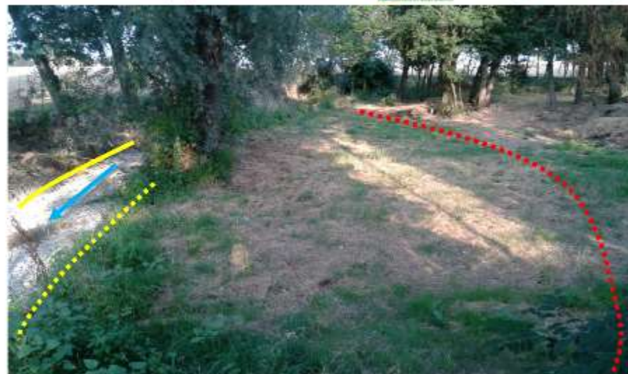
Sito di intervento ANTE OPERAM (15/01/2013) (vista da valle verso monte). In giallo continuo la sponda destra, in giallo tratteggiato la sponda sinistra pre intervento, in rosso la sponda sinistra dopo l'allargamento di sezione
