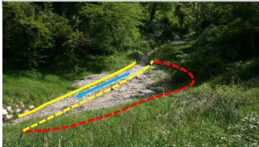
Sito di intervento durante il rilievo del 29/04/2016. In giallo continuo la sponda destra, in giallo tratteggiato la sponda sinistra pre intervento, in rosso la sponda sinistra arretrata.
