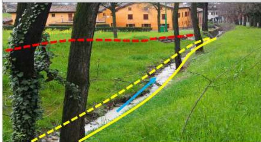
Sito di intervento durante il rilievo del 30/05/2015. In giallo continuo la sponda destra, in giallo tratteggiato la sponda sinistra pre intervento, in rosso la sponda sinistra arretrata.
