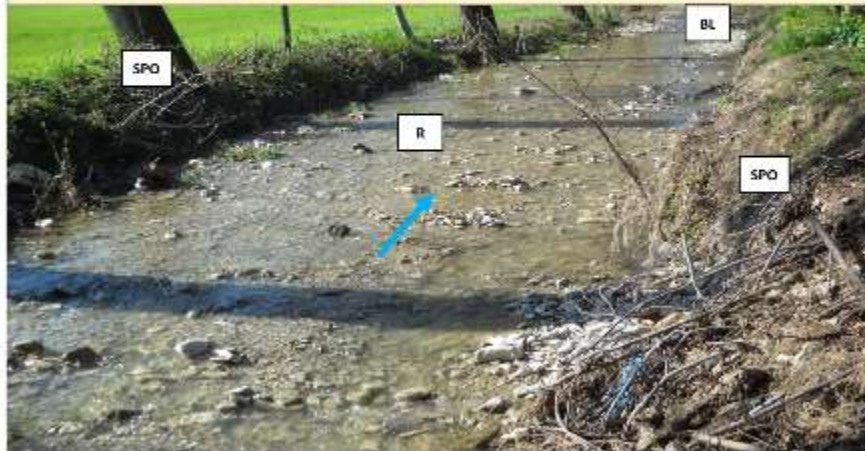
Rio Lavazza—Situazione pre lavori di posizionamento di TRONCHI CON RADICI ESPOSTE
