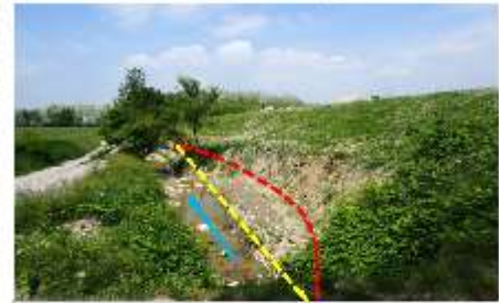
Una situazione di canale libero del Rio Enzola, in un tratto a valle della cascata, in cui il canale è stato allargato e il letto è stato ripulito.
