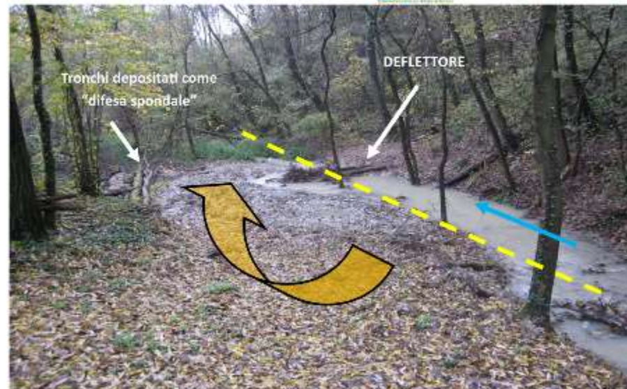
Rio Bertolini—Situazione dopo pochi mesi dal posizionamento del DEFLETTORE IN TRONCHI (10/11/2014). In giallo la sponda sinistra dell'alveo pre-intervento. In arancione la corrente deviata dall'intervento, con l'interessamento della piana inondabile.
