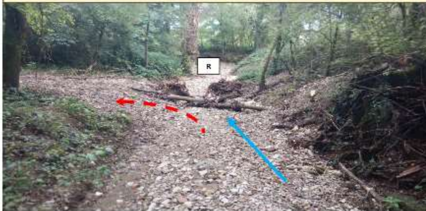
Rio Lavezza—Segmento 3e— Al termine dei lavori di posizionamento di SALTO DI FONDO CON RADICI ESPOSTE (16/10/2014). In ROSSO: andamento delle portate di piena verso la piana inondabile, riconnessa grazie all'innalzamento locale del fondo conseguente alla sistemazione in alveo dei tronchi
