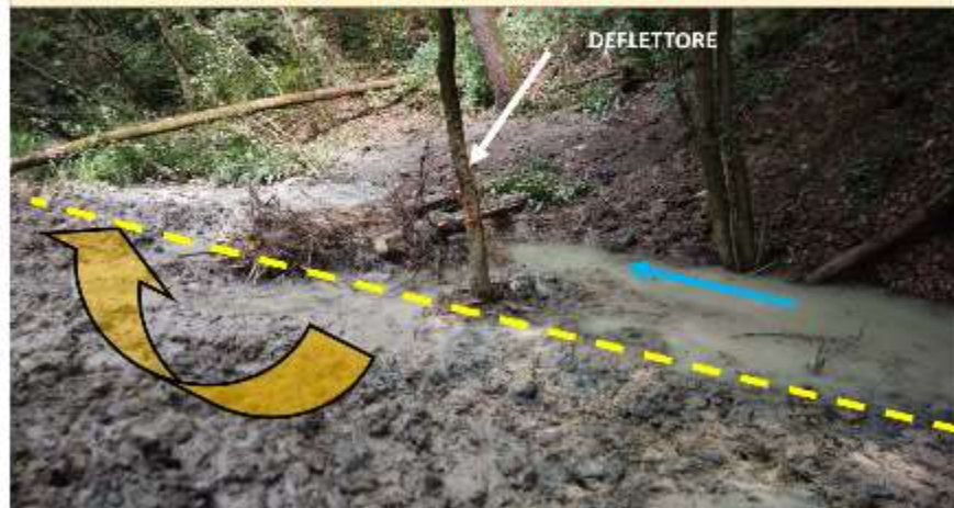
Rio Bertolini—Situazione successiva all'intervento di posizionamento del DEFLETTORE IN TRONCHI (21/08/2014). In giallo la sponda sinistra dell'alveo pre-intervento. In arancione la corrente deviata dall'intervento, con l'interessamento della piana inondabile.
