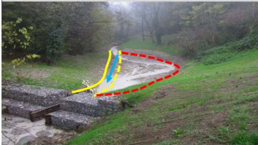
Sito di intervento durante il rilievo del 10/11/2014. In giallo continuo la sponda destra, in giallo tratteggiato la sponda sinistra pre intervento, in rosso la sponda sinistra arretrata.
