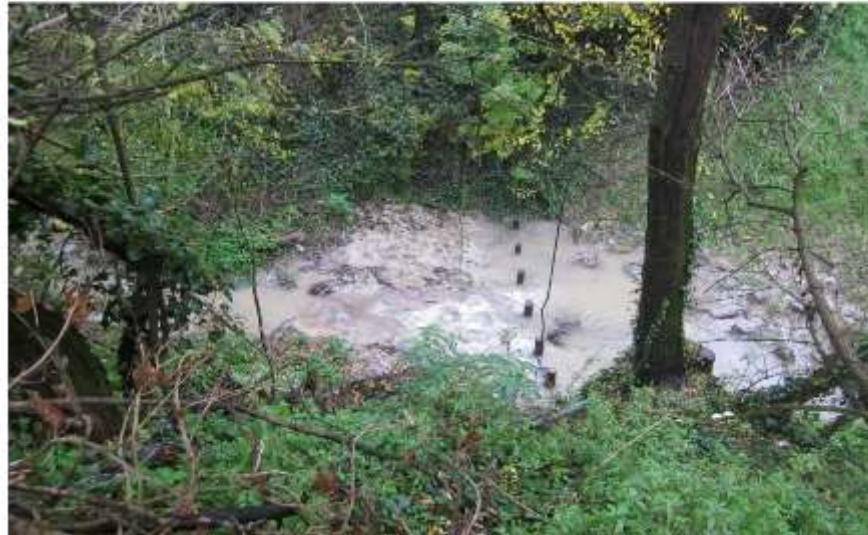
6 - Rampa in massi su briglia esistente
