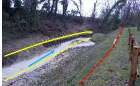
Una situazione di canale libero del Rio Enzola, in un tratto a valle della cascata, in cui il canale è stato allargato e il letto è stato ripulito.
