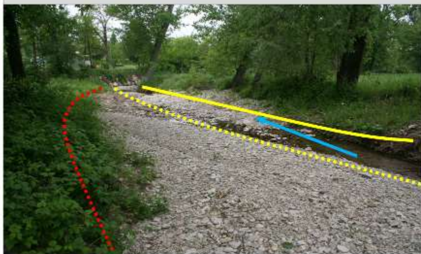
Sito di intervento POST OPERAM (25/04/2016) (vista da monte verso valle). In giallo continuo la sponda destra, in giallo tratteggiato la sponda sinistra pre intervento, in rosso la sponda sinistra dopo l'allargamento di sezione
