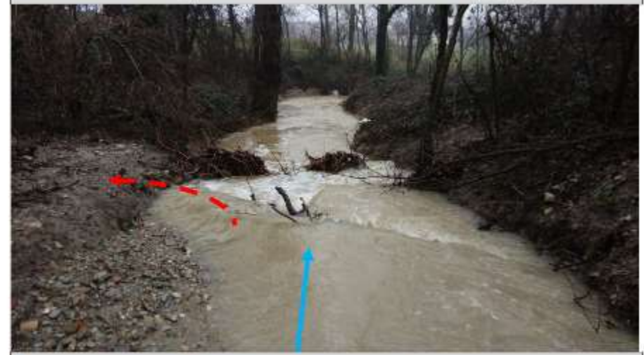
Rio Lavezza—Segmento 1-2—UNITÀ MORFOLOGICHE PRESENTI POST OPERAM (18/02/2015). In ROSSO: andamento delle portate di piena verso la piana inondabile, riconnessa grazie all'innalzamento locale del fondo conseguente alla sistemazione in alveo dei tronchi
