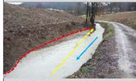
Una situazione di canale libero del Rio Enzola, in un tratto a valle della cascata, in cui il canale è stato allargato e il letto è stato ripulito.
