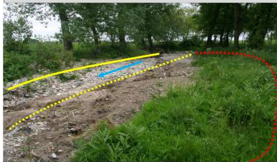
Sito di intervento POST OPERAM (29/04/2016) (vista da valle verso monte). In giallo continuo la sponda destra, in giallo tratteggiato la sponda sinistra pre intervento, in rosso la sponda sinistra dopo l'allargamento di sezione
