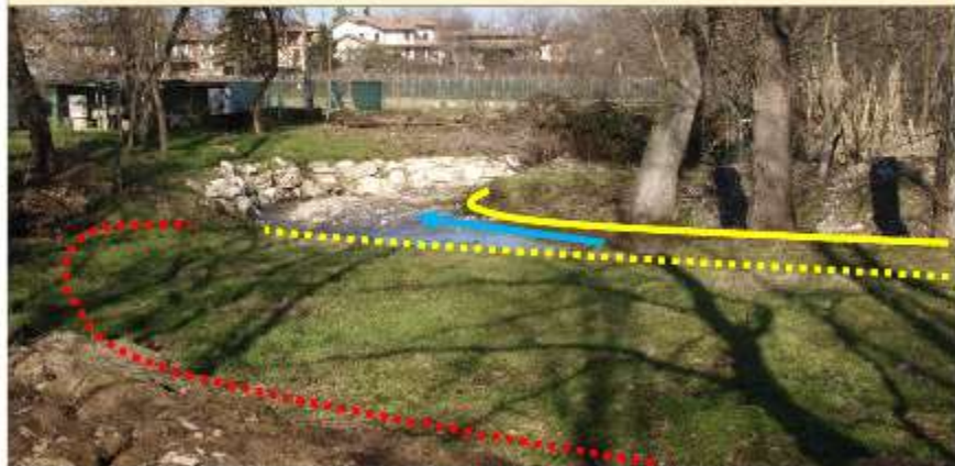
Sito di intervento ANTE OPERAM (05/02/2013) (vista da monte verso valle). In giallo continuo la sponda destra, in giallo tratteggiato la sponda sinistra pre intervento, in rosso la sponda sinistra dopo l'allargamento di sezione
